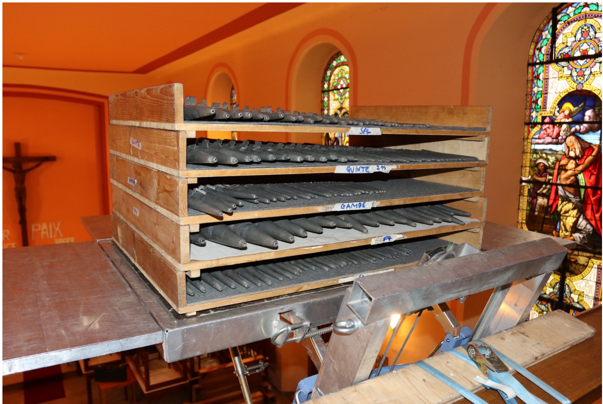
Le démontage de la tuyauterie.
