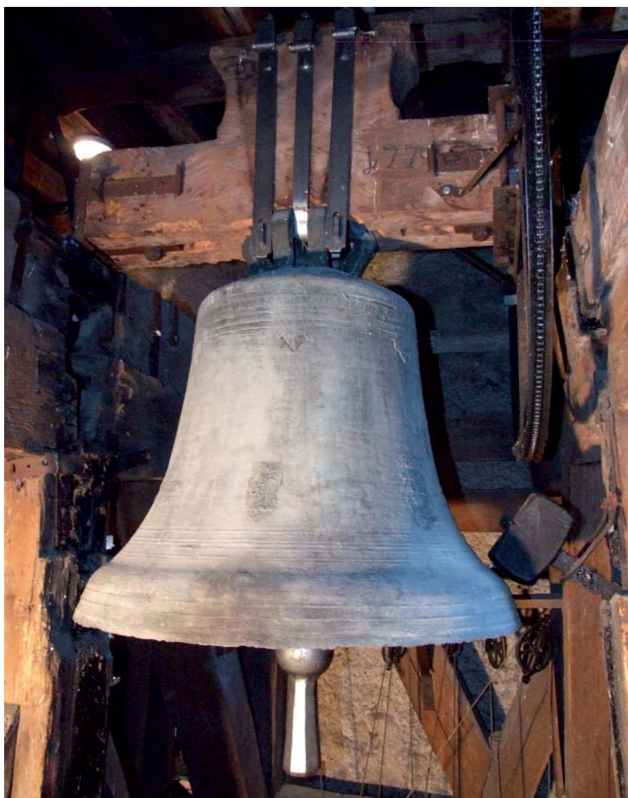
Eglise Notre-Dame de Sewen (Haut-Rhin). Cloche Fa dièse , coulée en 1807, équipée d'un joug en bois du 18 e siècle, d'un battant neuf forgé à la main, de brides plates forgées à la main et d'un marteau de tintement en mode «tiré lâché».
