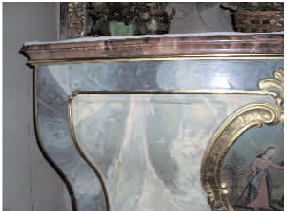
Faux marbre de l'église Saint-Léger de Kogenheim - Photo : Guy Vetter
