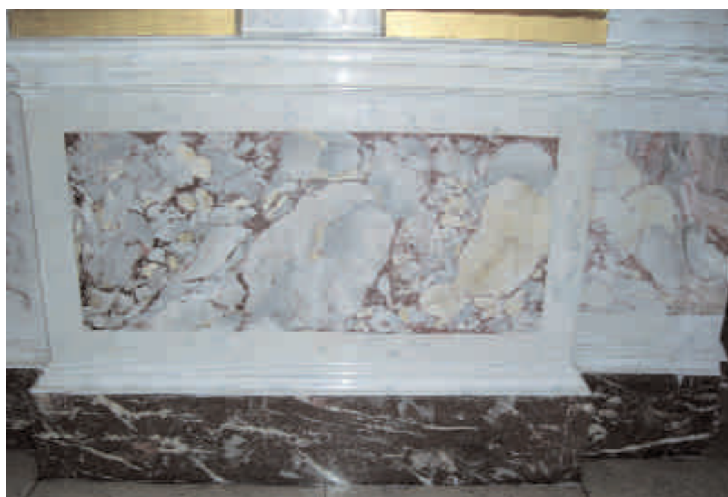
Stuc marbre de la chapelle du Château des Rohans à Strasbourg Photo : Guy Vetter
