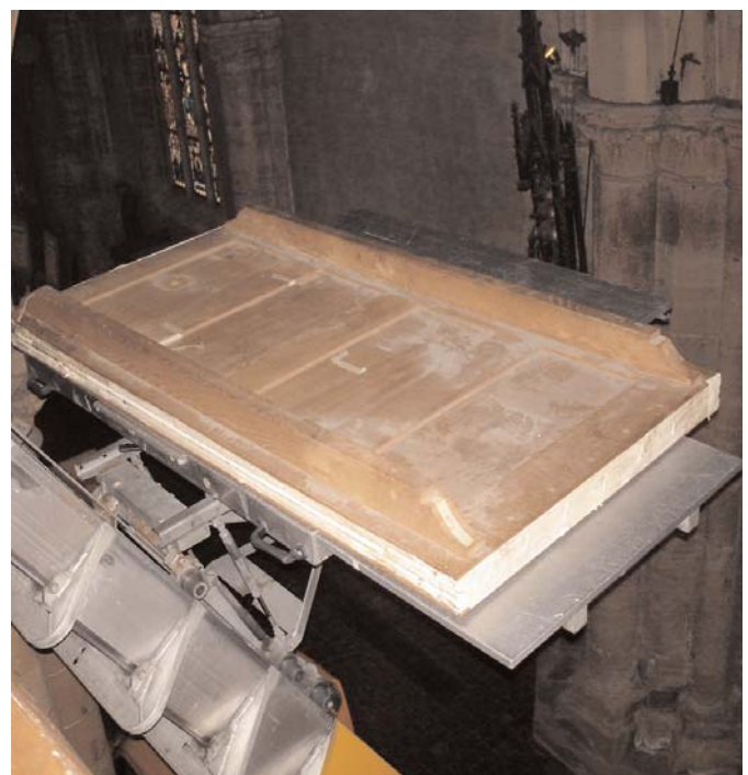
Soufflet cunéiforme de l'orgue, déplacé pour réparation.
